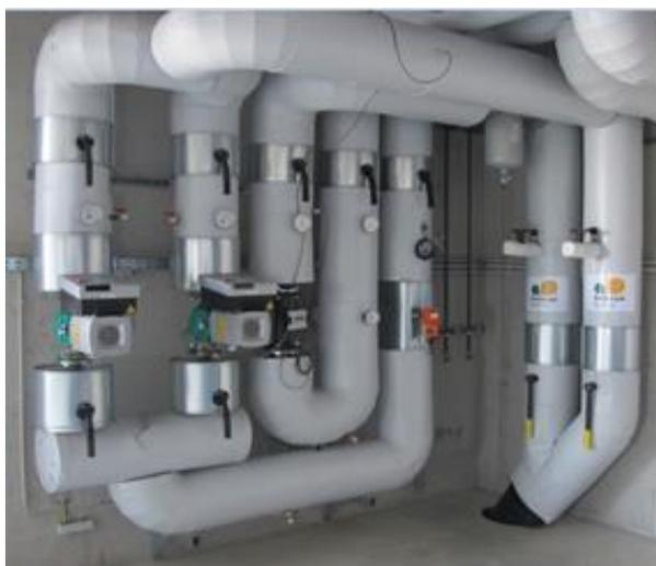
**Bild 12: Wärmeverteilung im Heizhaus im Bioenergiedorf Heubach-Buch** Quelle: © UM
