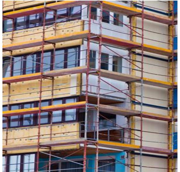
**Bild 10: Fassadendämmung an einem Gebäude.**
