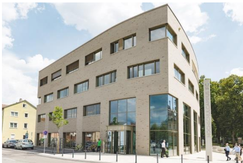
Die Architektur des IFC Tuttlingen kennzeichnet sich durch klare Formen. © HFU
