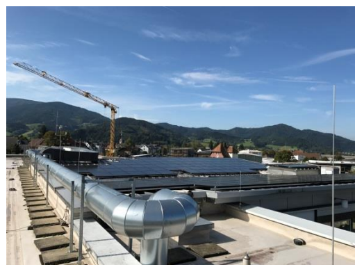
Abbildung 7: Solar- und Klimaanlage für die Versorgung der Gebäude der Testo Industrial Services in Kirchzarten, Bildquelle: Fraunhofer ISE
