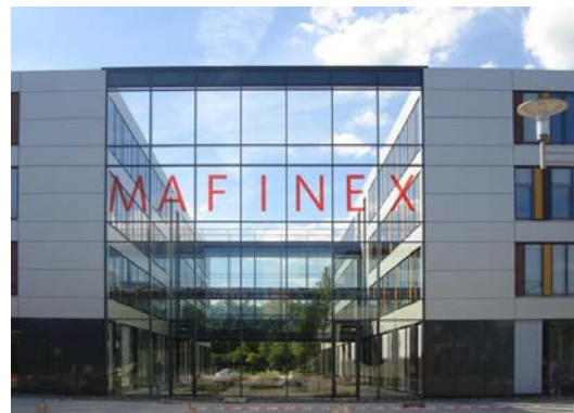
Abbildung 43: Frontansicht Fassade © MAFINEX Technologiezentrum
