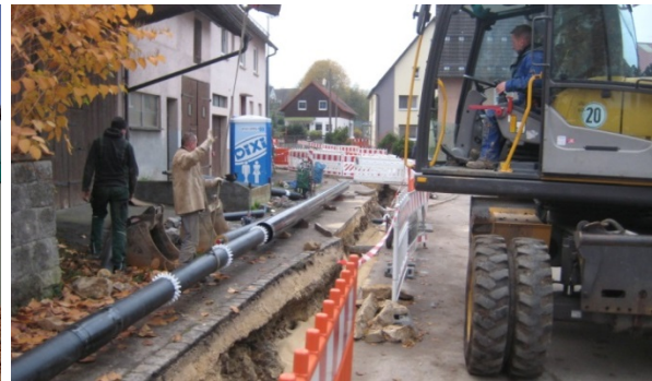
Abbildung 68: Rohre werden verlegt © Energiegenossenschaft Gussenstadt eG
