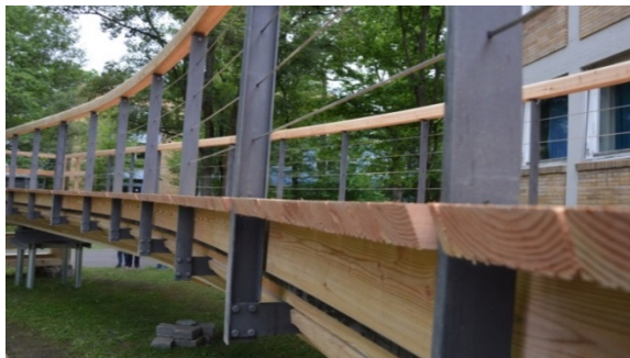
Abbildung 37: Der Prototyp der Stuttgarter Holzbrücke © Jost proHolzBW
