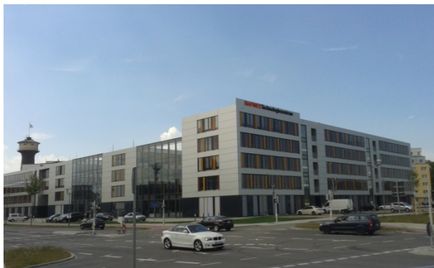
Abbildung 42: MAFINEX-Technologiezentrum: 1. und 2. Bauabschnitt © Stefan Grether
