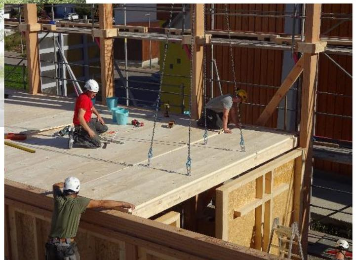
**Abbildung 14:** Holzelemente werden zusammengesetzt,
