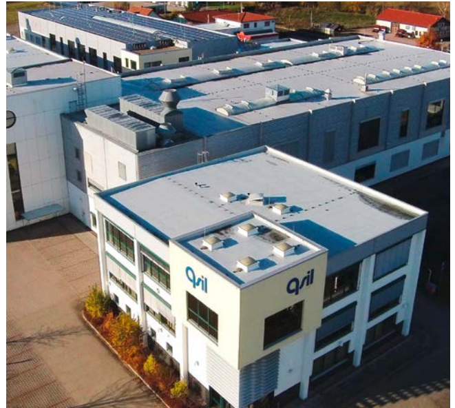
Das Firmengelände der Qsil GmbH in Langwiesen
