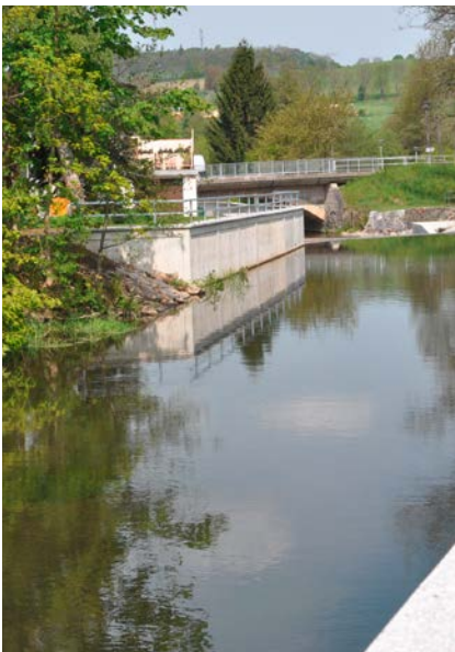
Ein neues Wehr mit Fischauftiegsanlage
